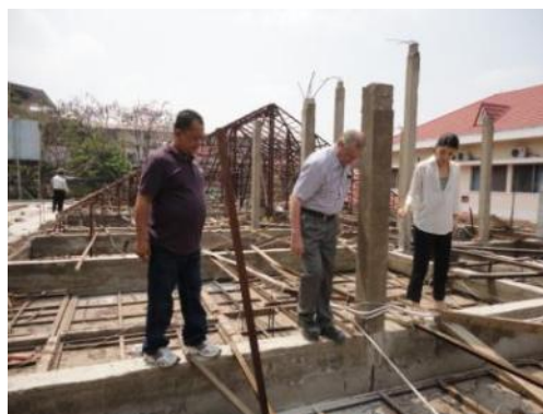
手術棟拡張工事のモニタリングを行うFIDR職員(中央・右)
