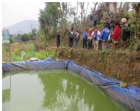
震災後に修復した農業用ため池
